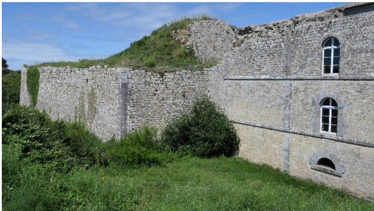
Hœdic, fort central, bastion nord-ouest.
