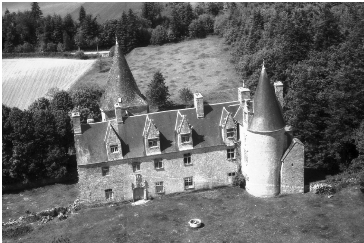
Vue générale prise du sud
