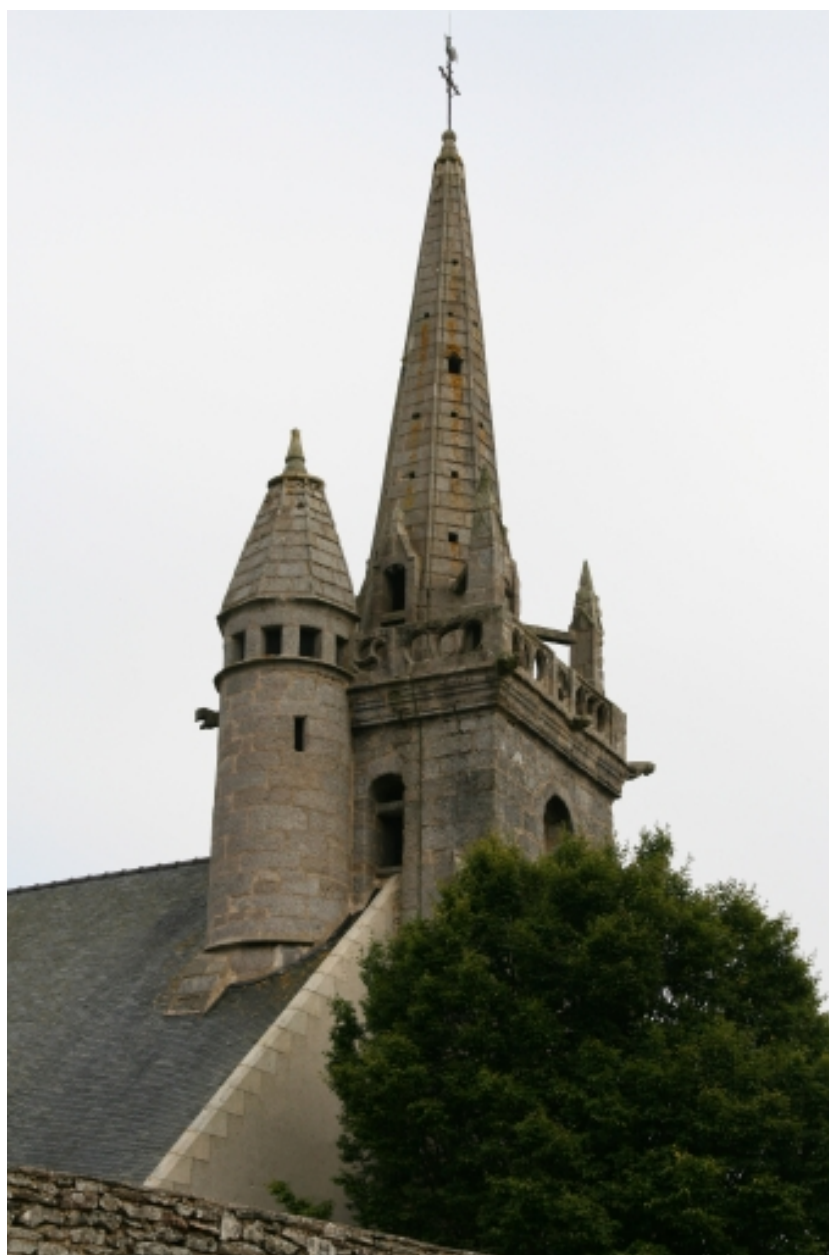
Face nord-ouest du clocher
