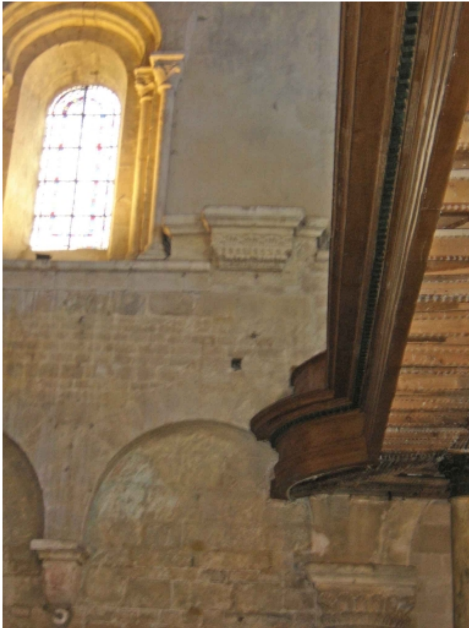
Élévation intérieure Sud de la nef : détail de la 1ère travée
