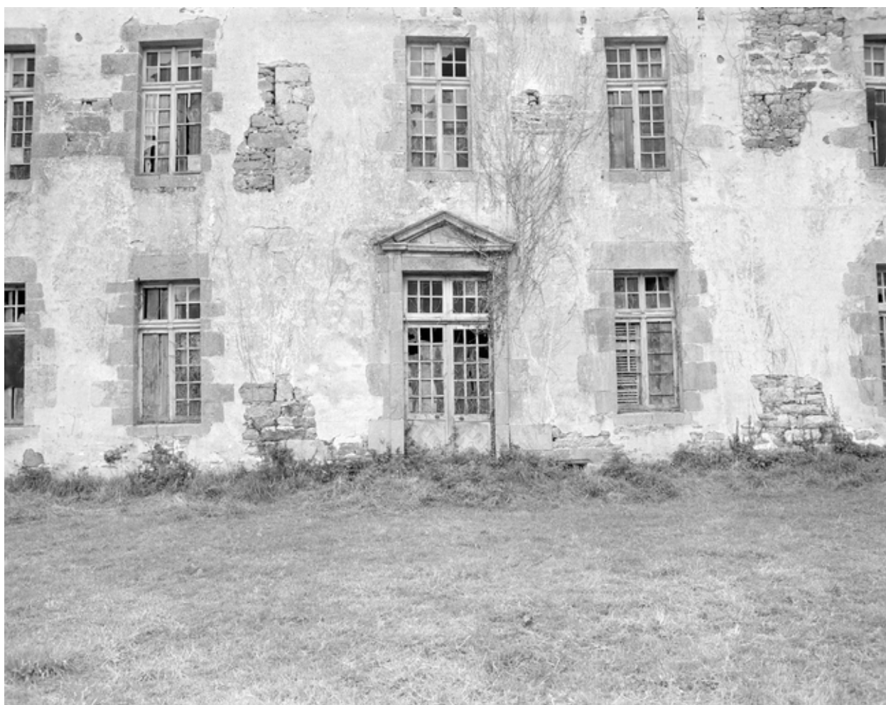
Logis principal : porte nord
