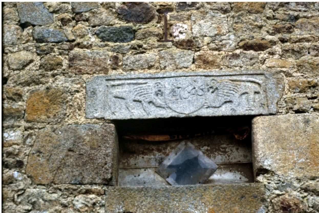
La Basse Biliais : linteau fenêtre communs sud
