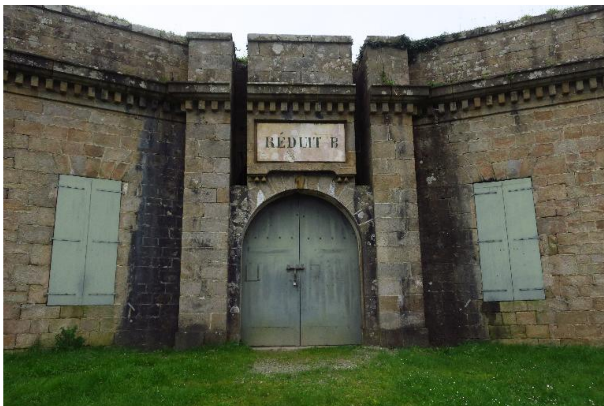
Le Palais, enceinte urbaine, réduit B, façade de gorge, porte.
