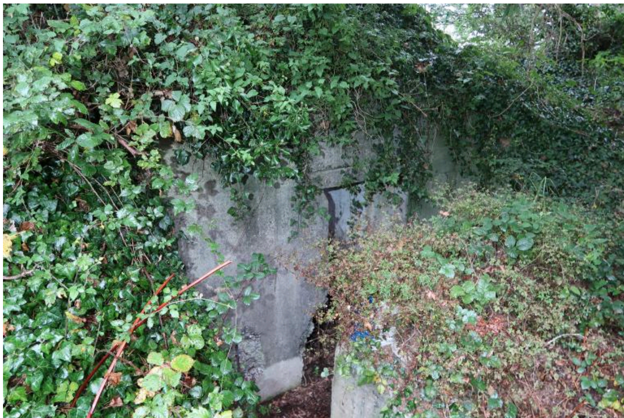
Vue de l'accès par l'arrière de la casemate (état en 2021)
