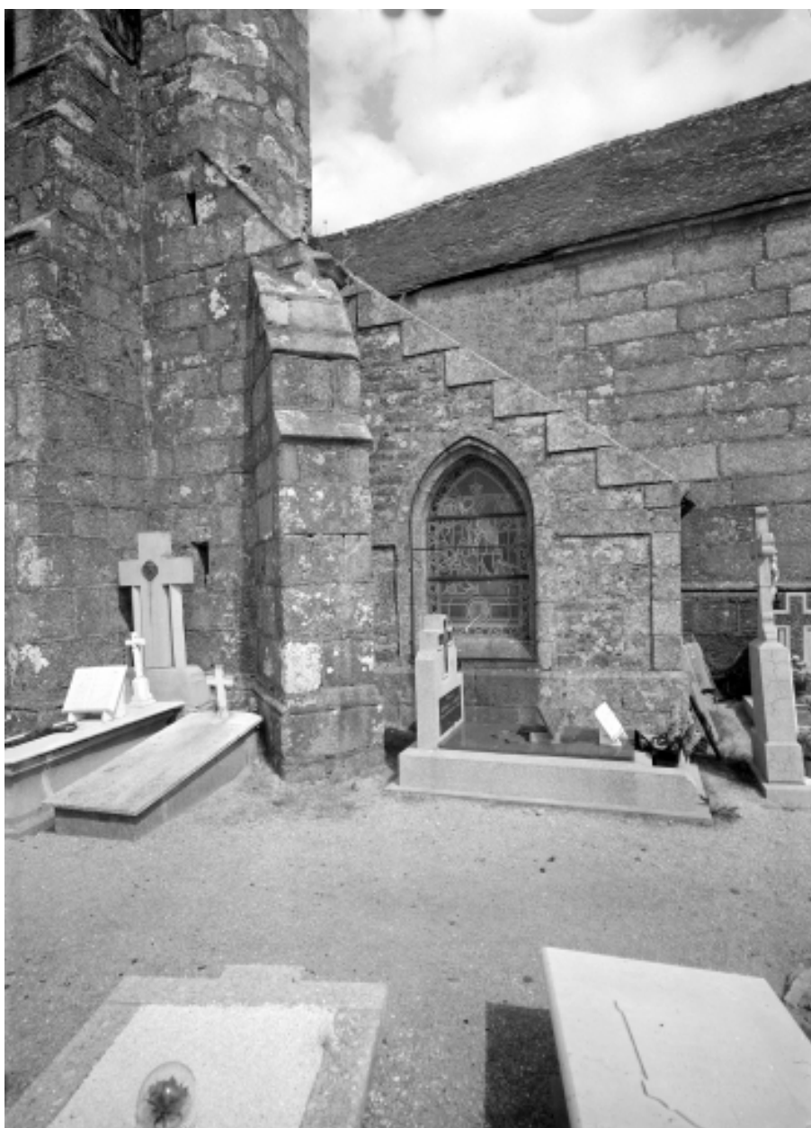
Chapelle des fonts, face ouest
