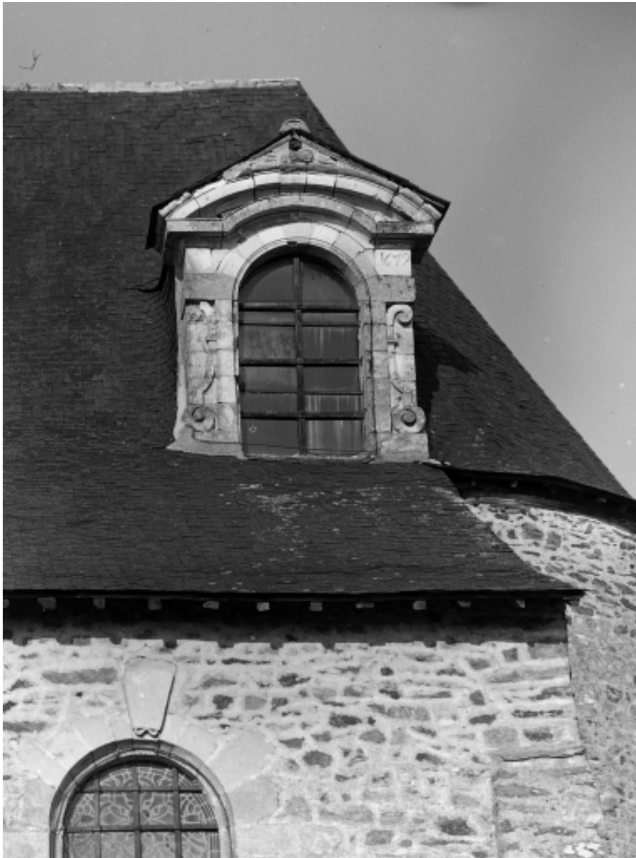
Lucarne sud-est, vue de détail.
