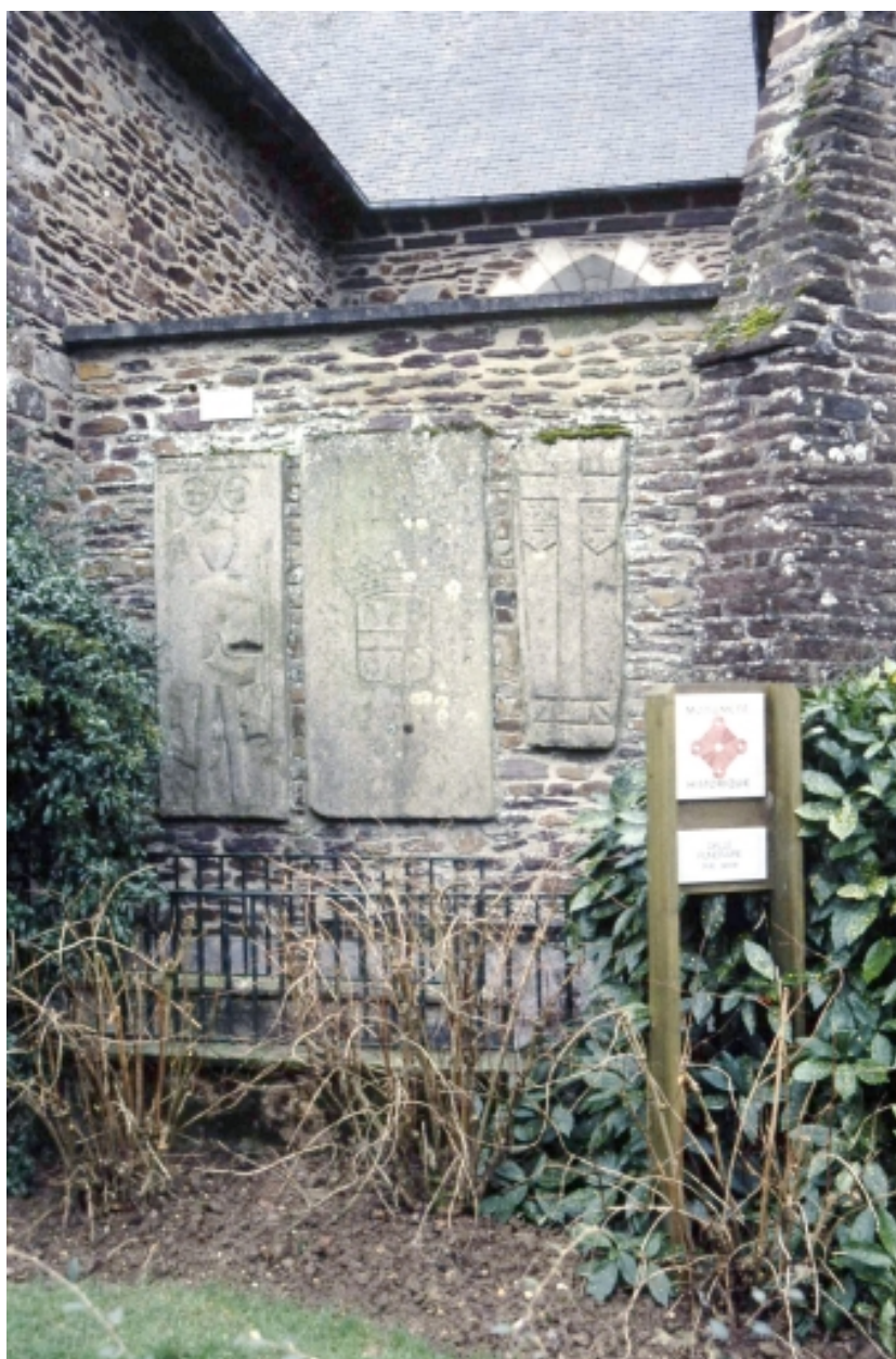
Pierres tombales sur la façade nord.
