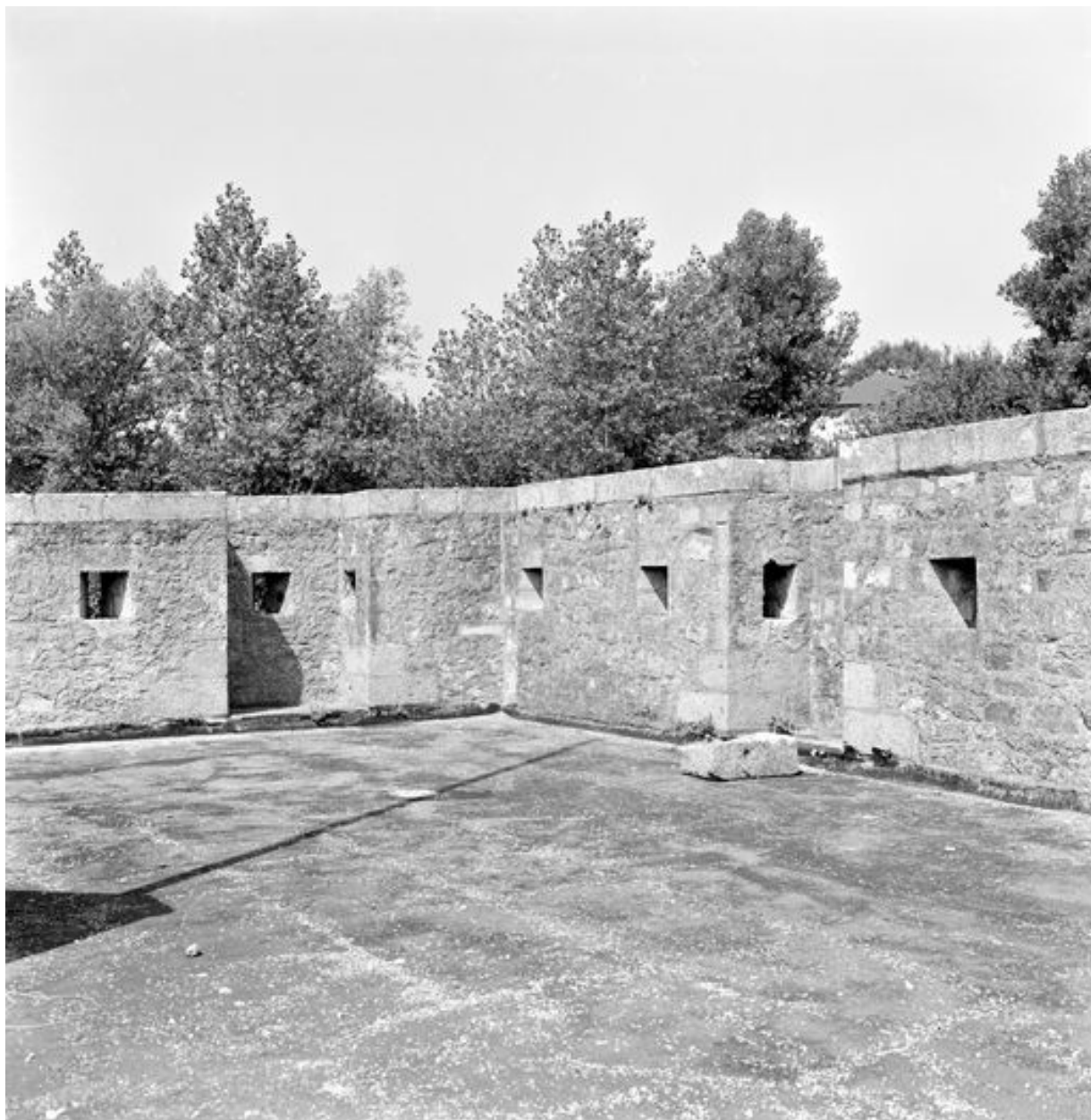
Vue du corps de garde crénelé n° 3 du bourg de Roscanvel en 1969 : terrasse et parapet percé de créneaux de fusillade
