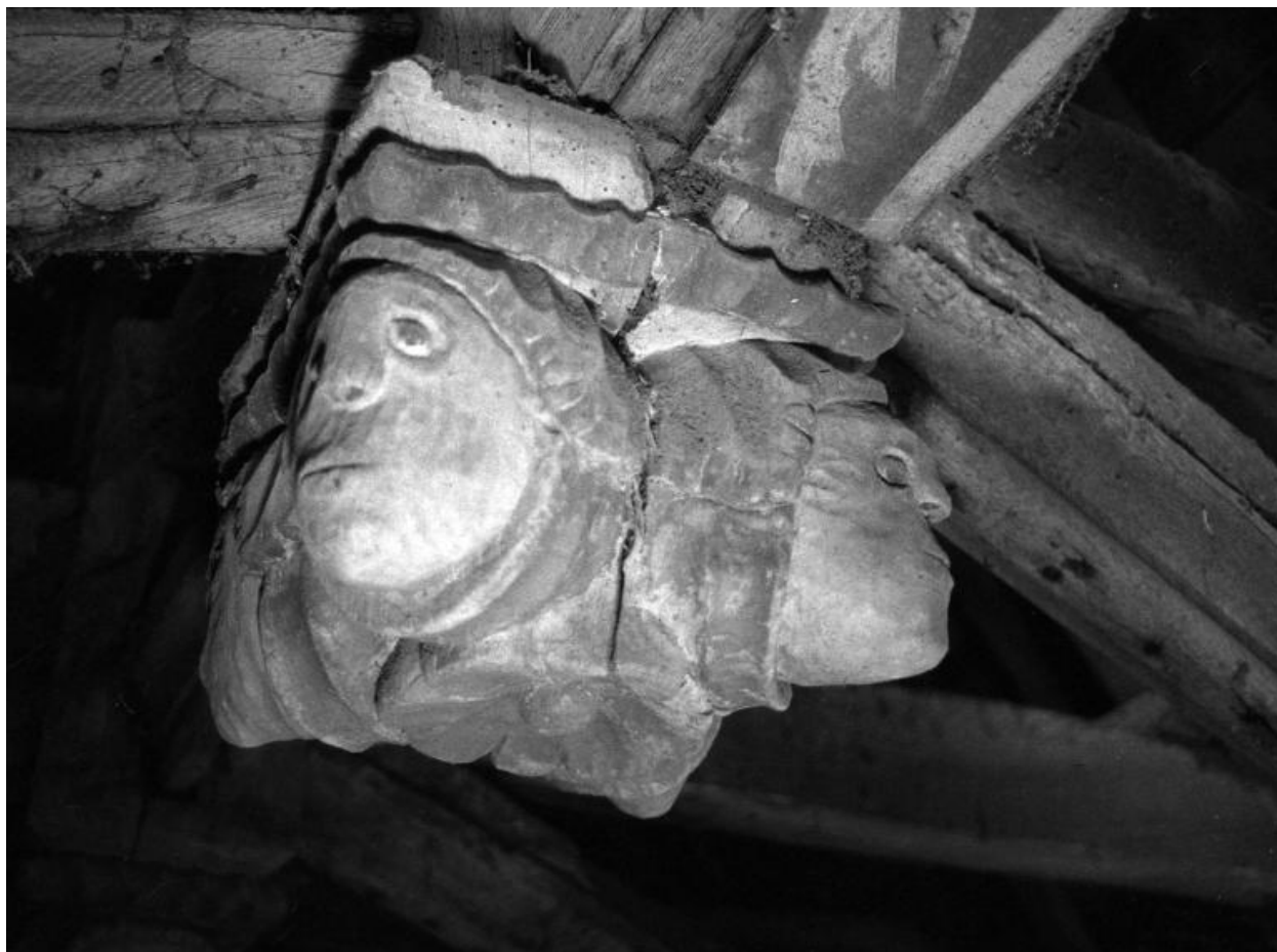
Charpente, détail de la clé 21.
