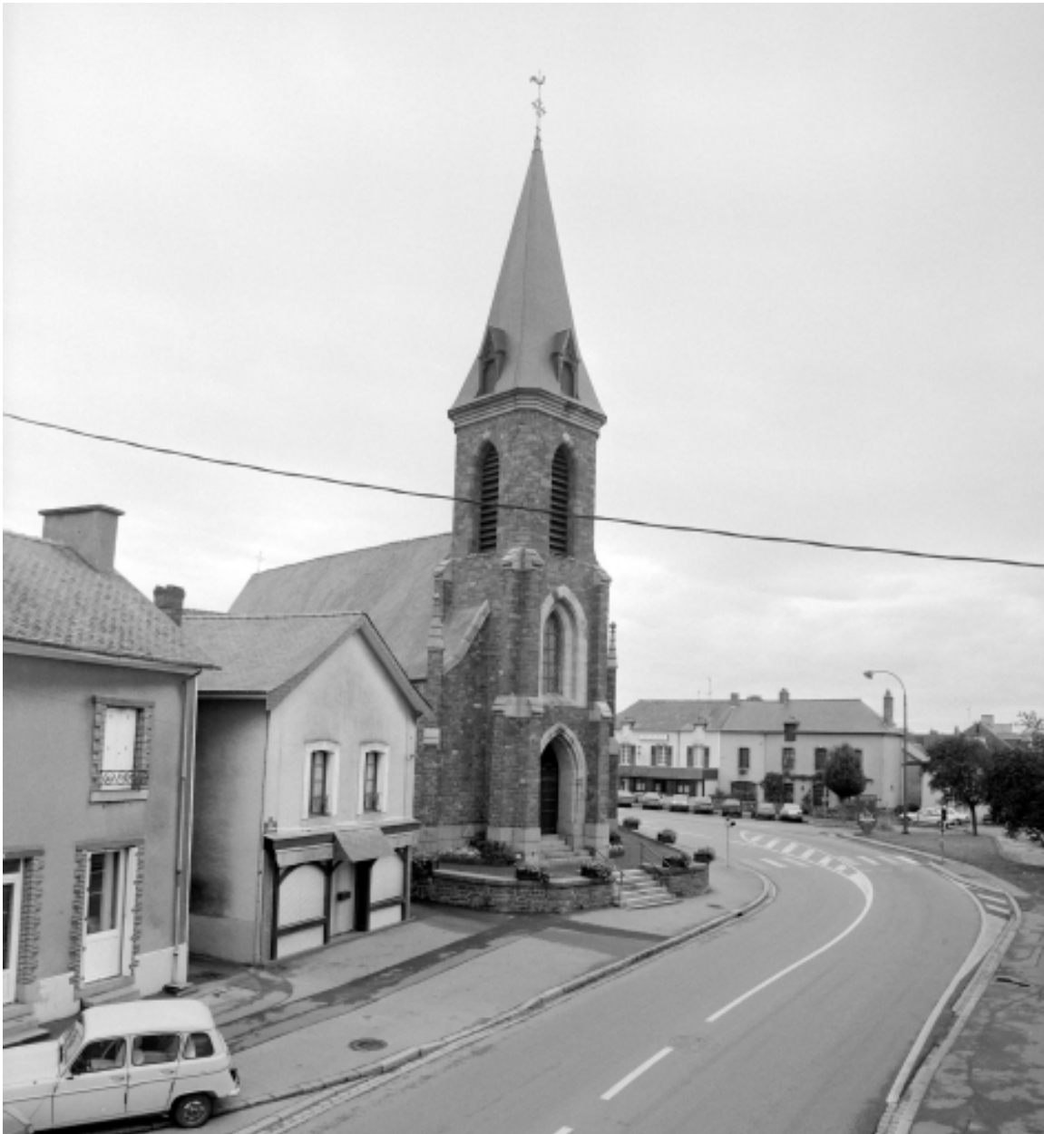
Elévation Ouest : vue générale
