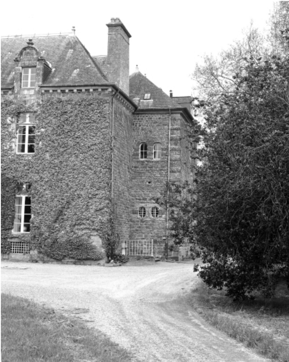
Pavillon est : élévation sud, vue générale.
