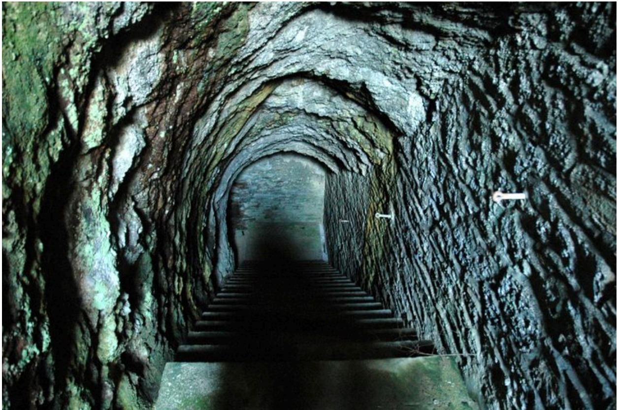
Vue de l'escalier - galerie d'accès (état en 2005)
