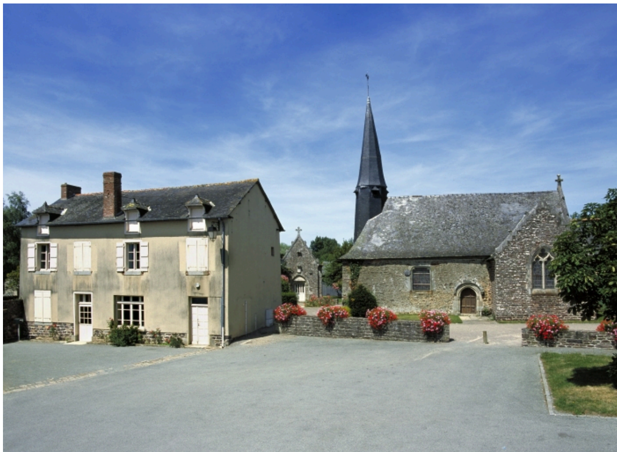
Vue de situation sud
