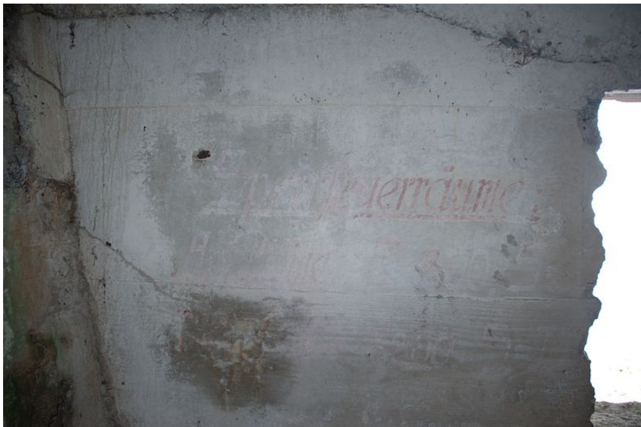
Vue intérieure : instructions de tir peintes à proximité de l'embrasures (état en 2007)
