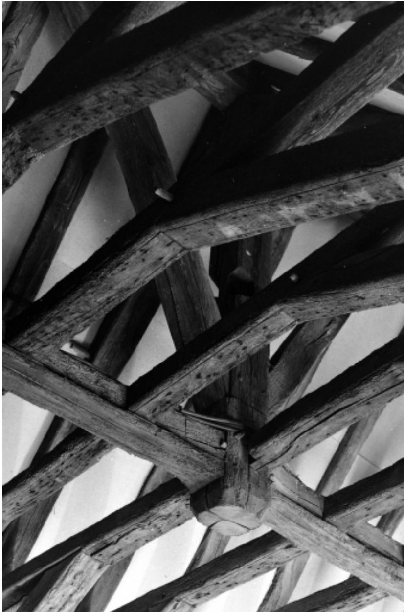
Intérieur, nef, charpente : détail sous le faitage.
