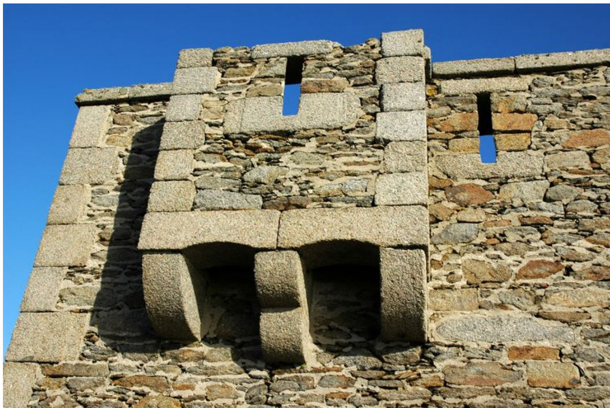
Elévation Ouest : détail de la bretèche Nord
