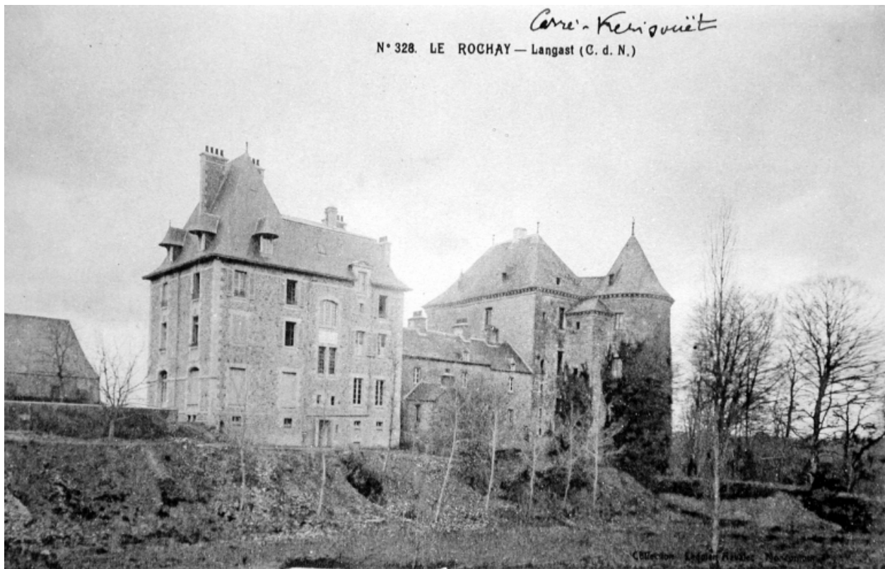
Vue générale des élévations postérieures
