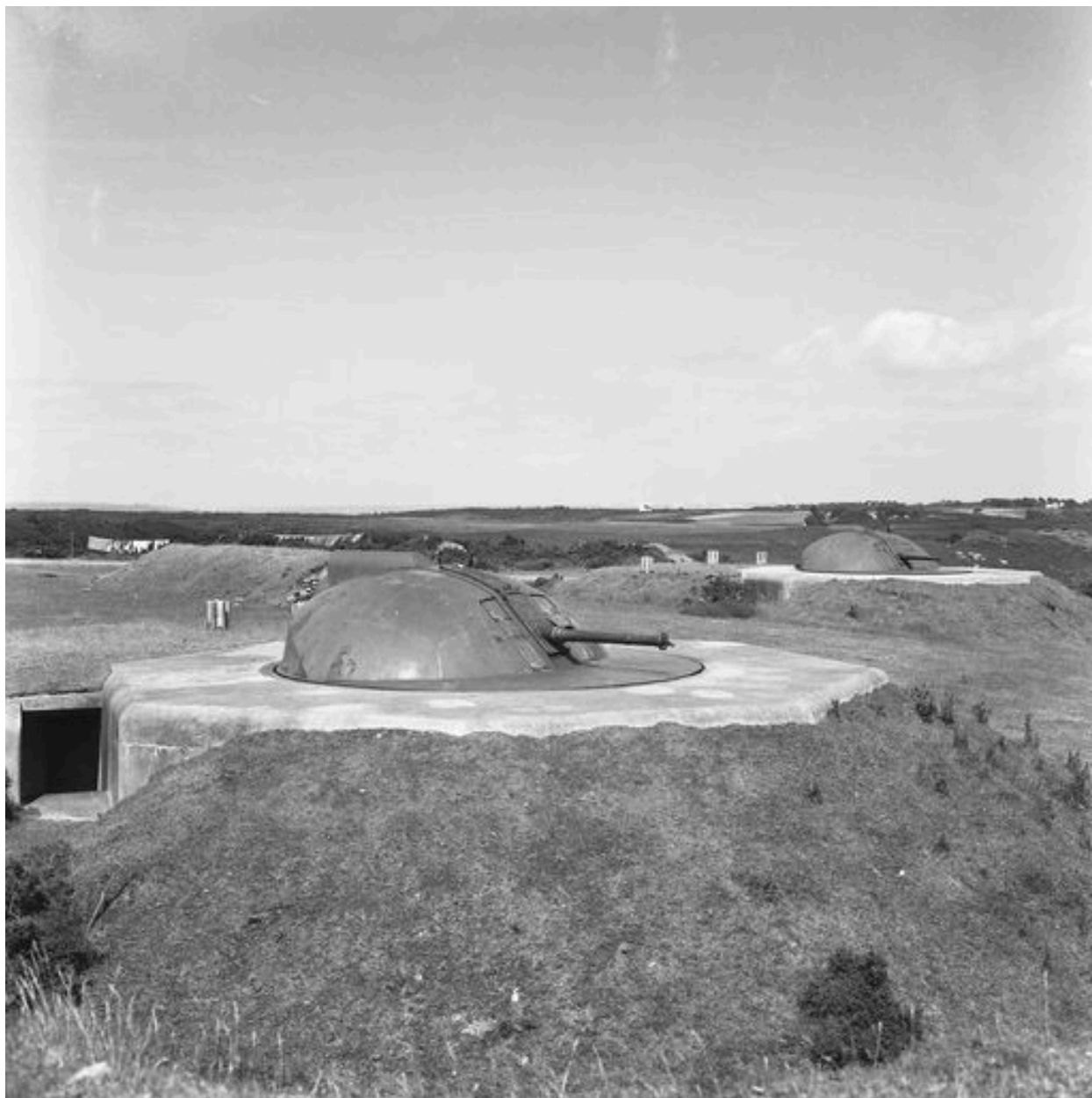
Vue de deux des quatre canons antiaériens de 10,5 cm sous blindage (état en 1969)
