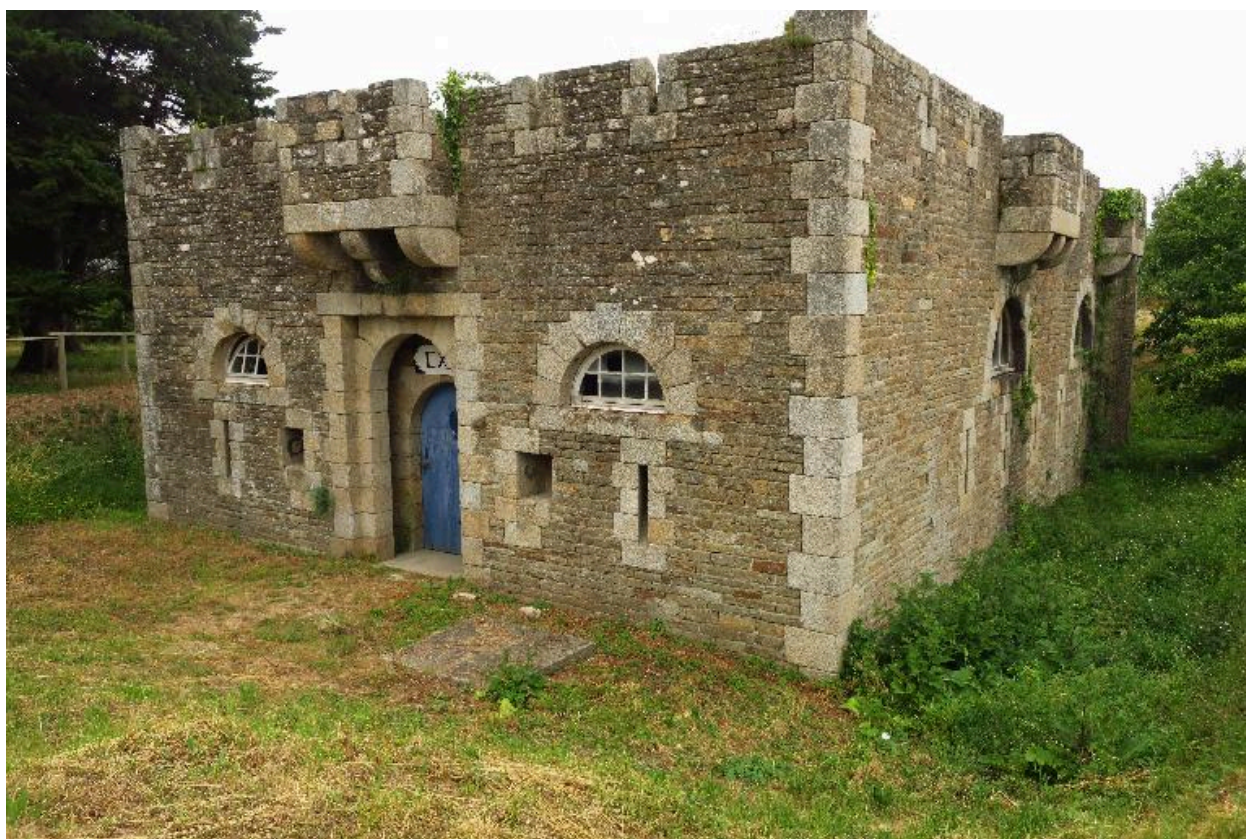
Groix, batterie du Gripp, corps de garde crénelé, angle sud-est.
