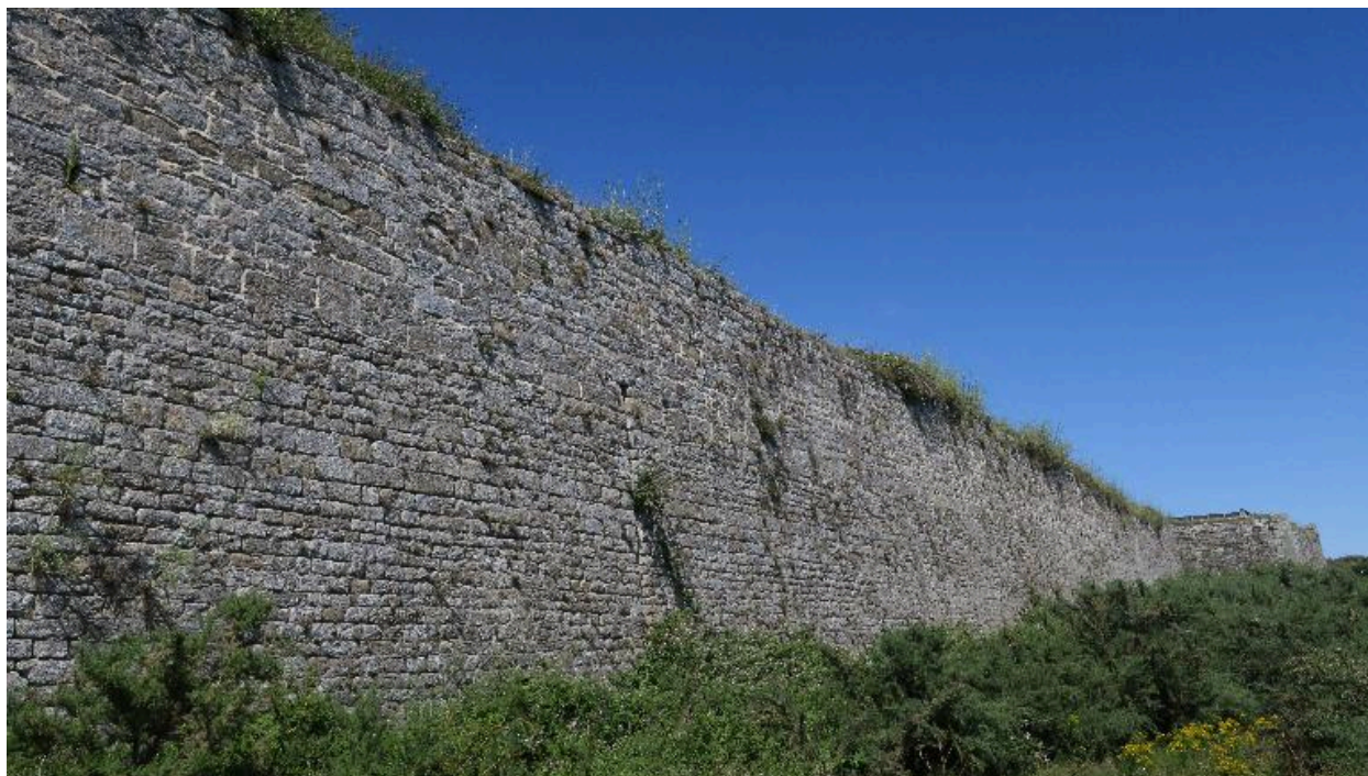
Hœdic, fort central, escarpe du front sud.
