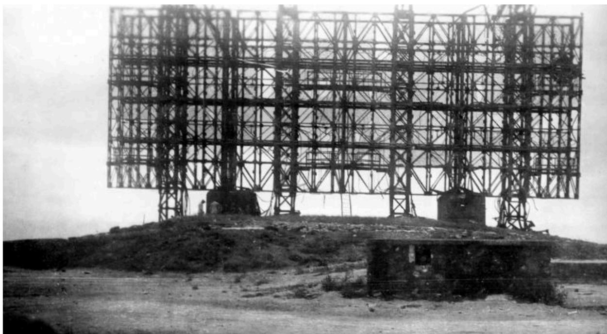
Vue de l'antenne du radar Mammut de Men Tan sur son bunker de type L 485, 1944. La construction au premier plan, dont la fonction n'est pas identifiée, a disparu
