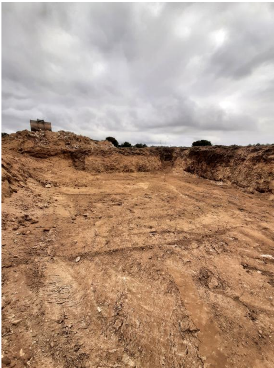
Vue de la fouille après déconstruction (4 octobre 2022)
