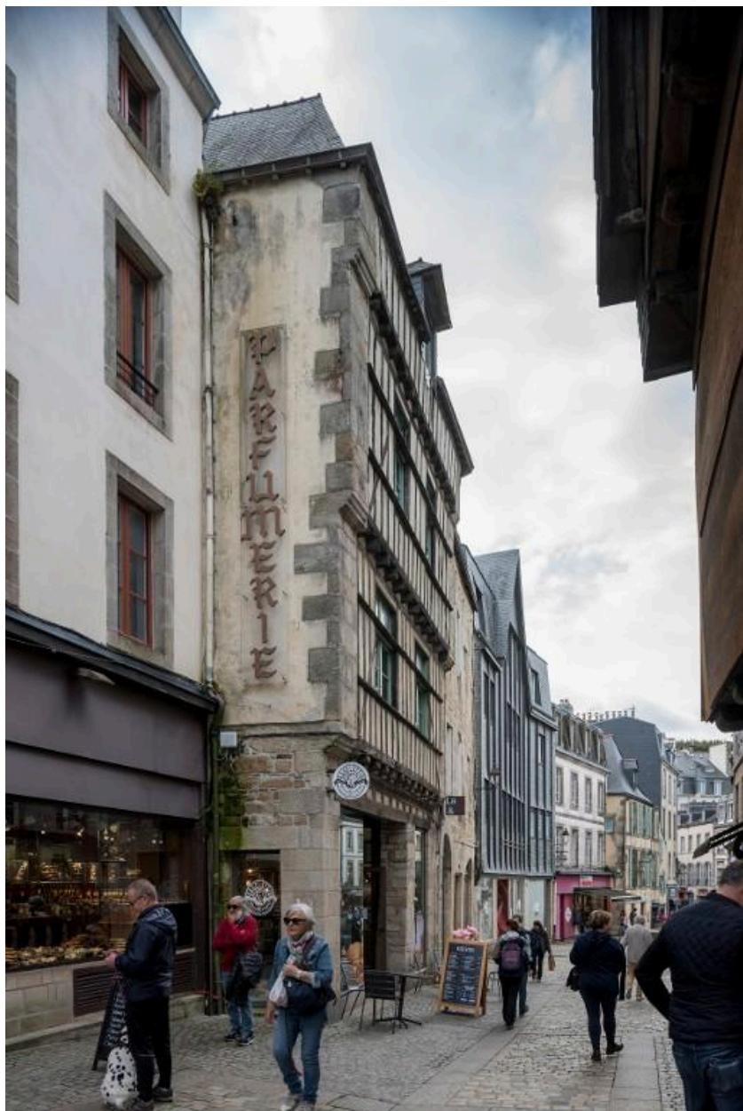
Ce mur à ressauts permet l'ancrage de l'encorbellement des deux étages et du surcroît.
