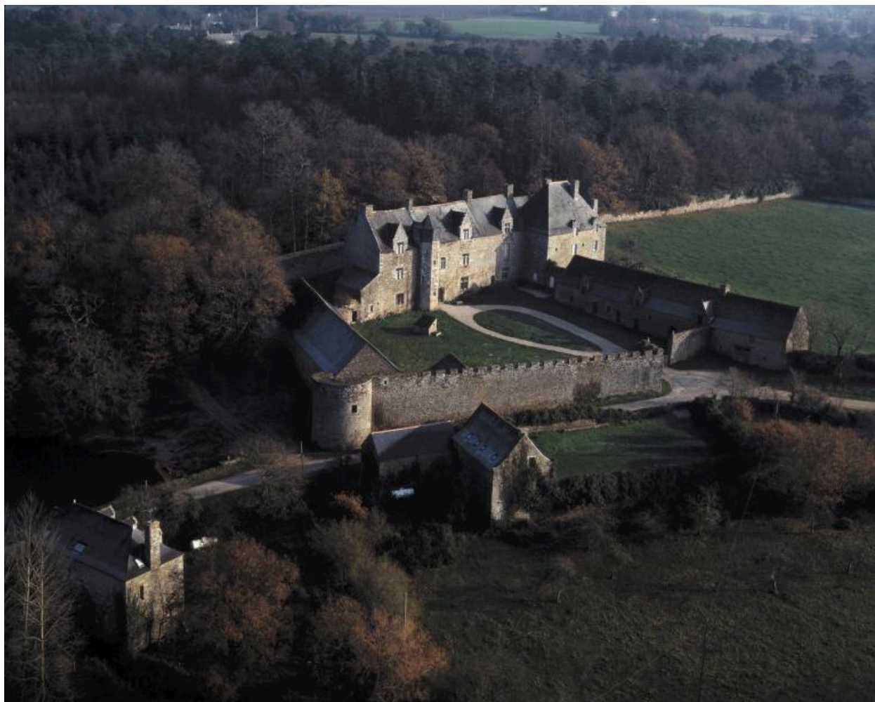
Manoir du Plessis Josso (Theix) : Vue aérienne depuis le sud
