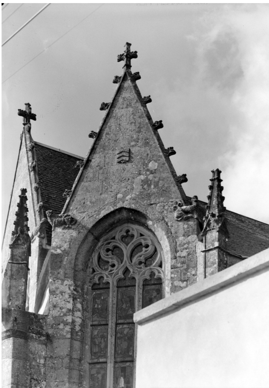
Fenêtre nord est du chevet, détail : gâble
