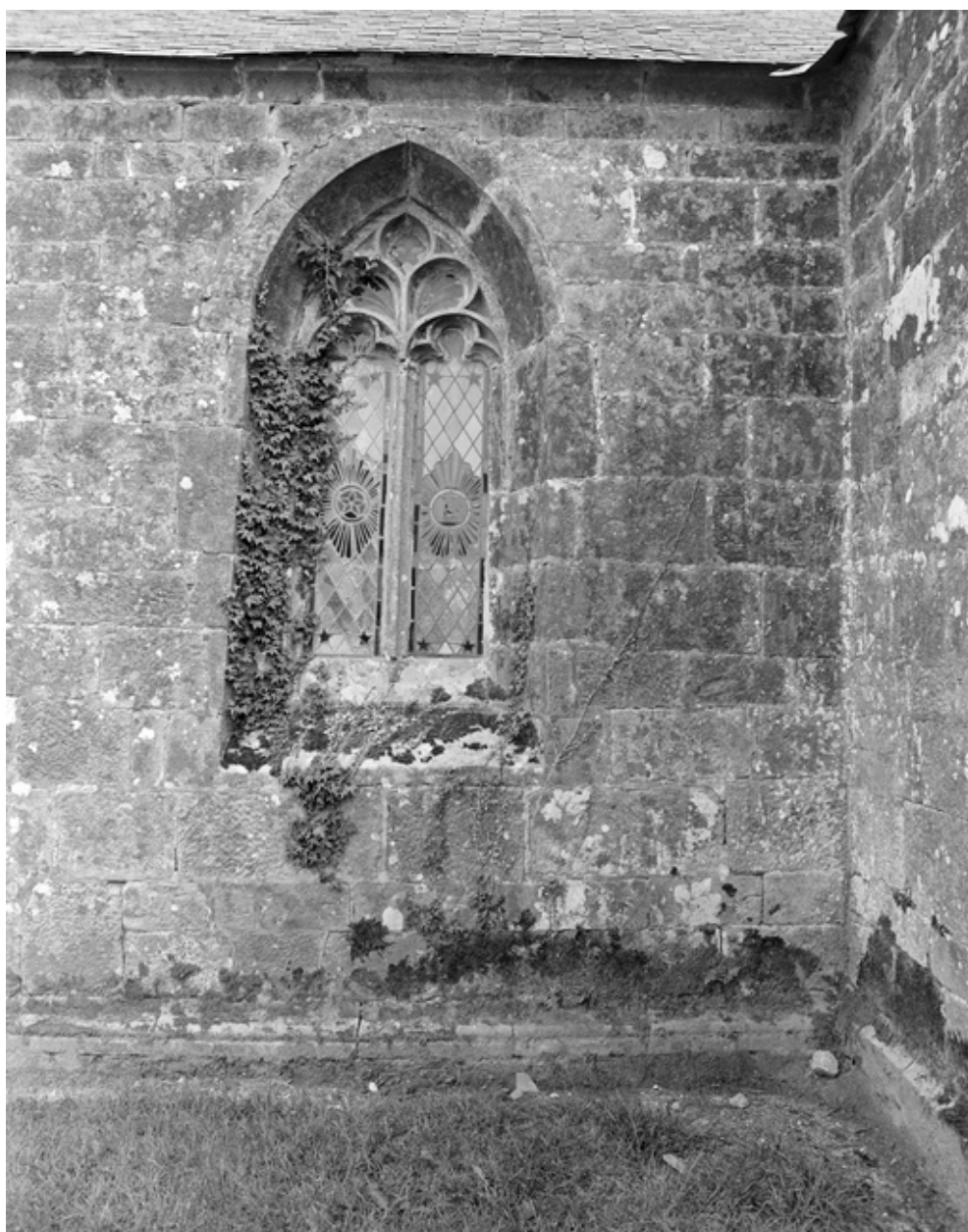
Choeur : vue de la fenêtre nord
