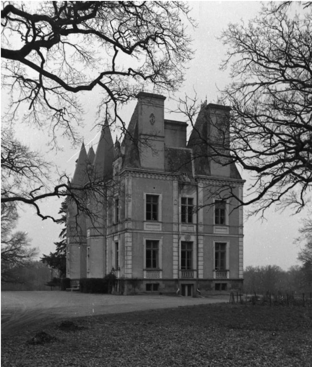
Vue générale de la face est.
