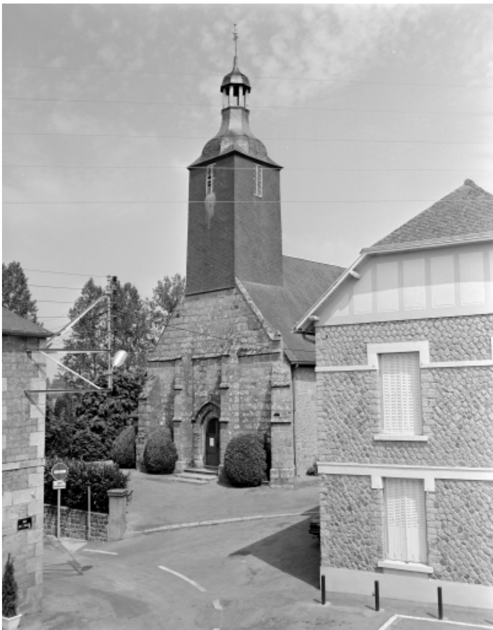
Elévation Ouest : vue générale
