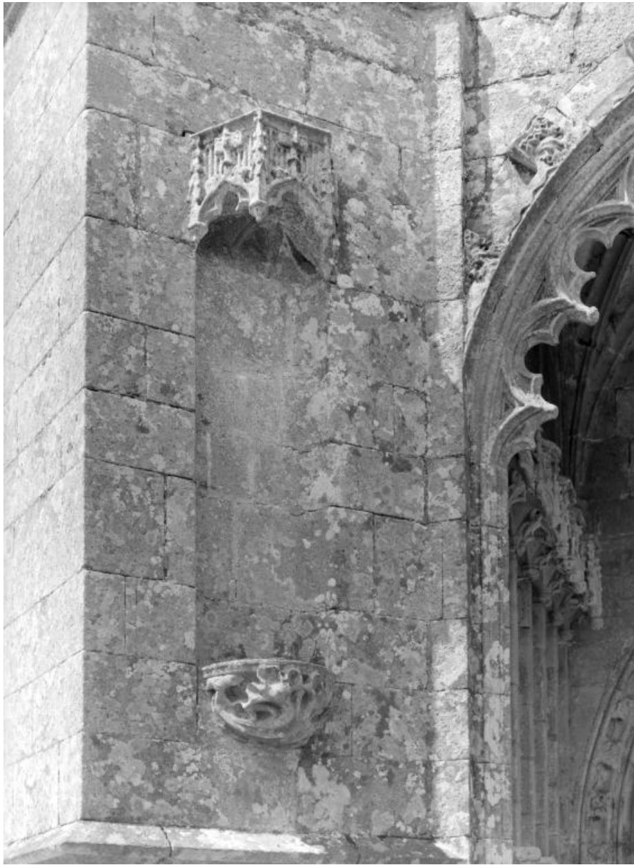
Niche du contrefort sud-ouest du porche sud.
