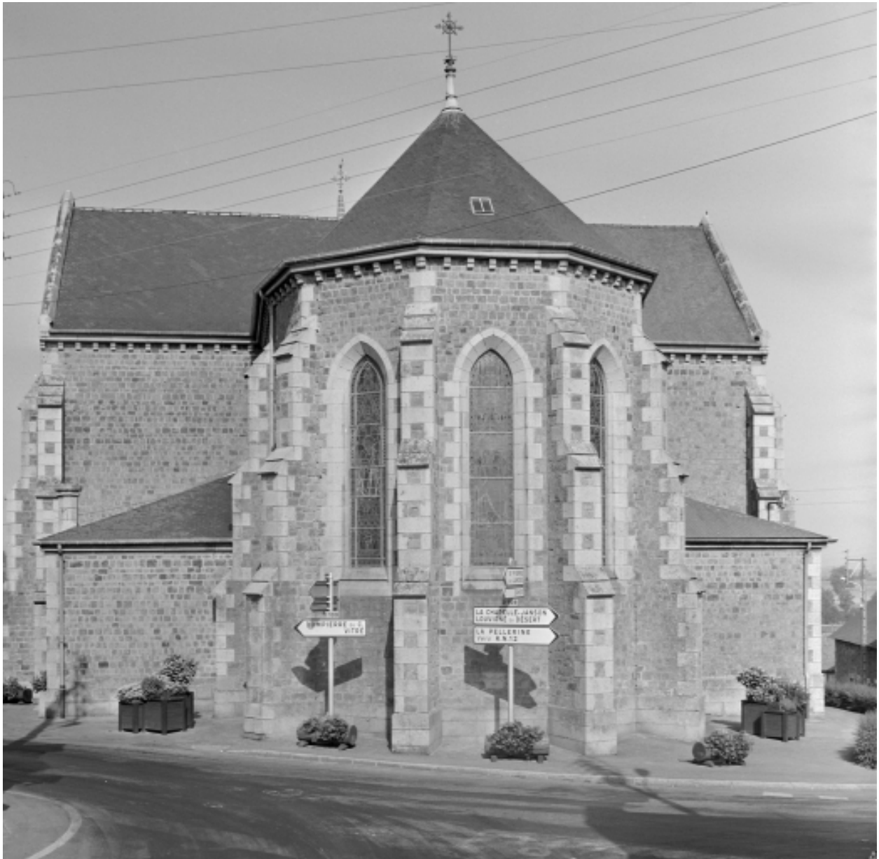
Elévation Est : vue générale
