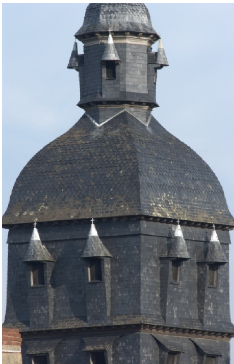
Vue de l'étage du clocher
