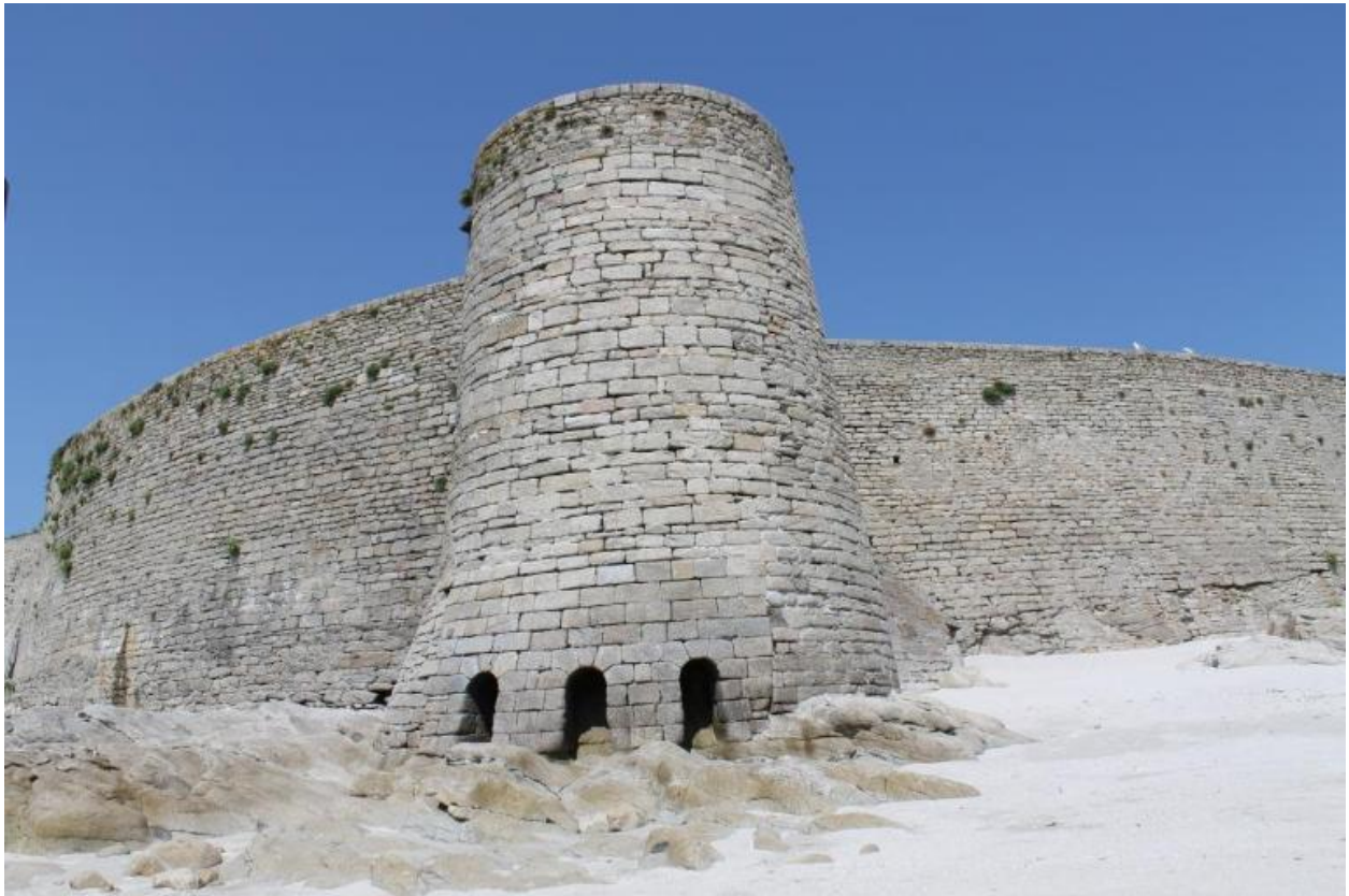
Vue extérieure des évacuations des lieux d'aisance
