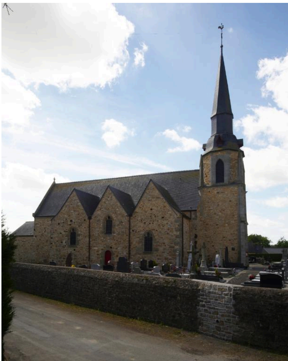
Vue générale nord
