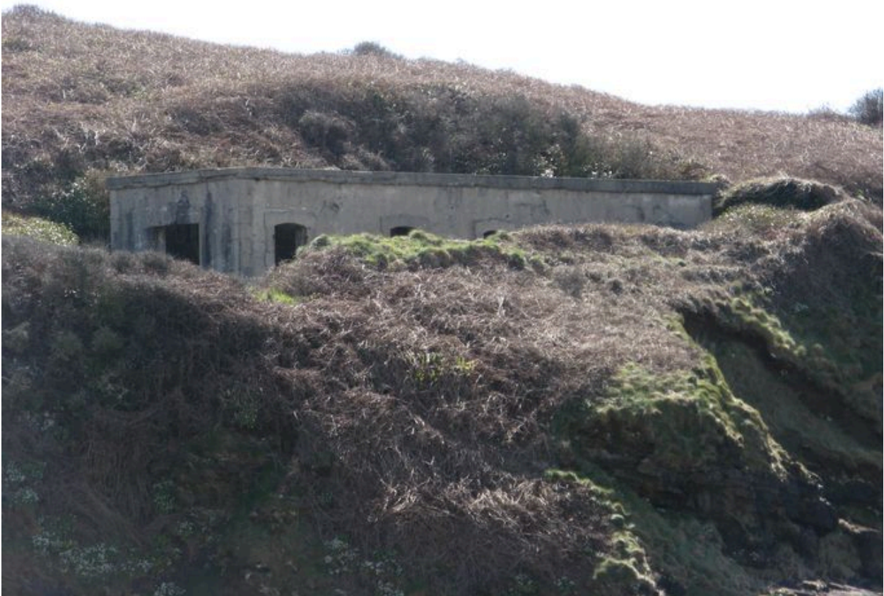
Usine électrique de l'îlot du Diable servant à l'alimentation du projecteur
