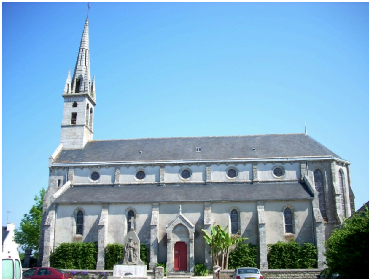
Pleuven, église paroissiale Saint-Mathurin : élévation sud
