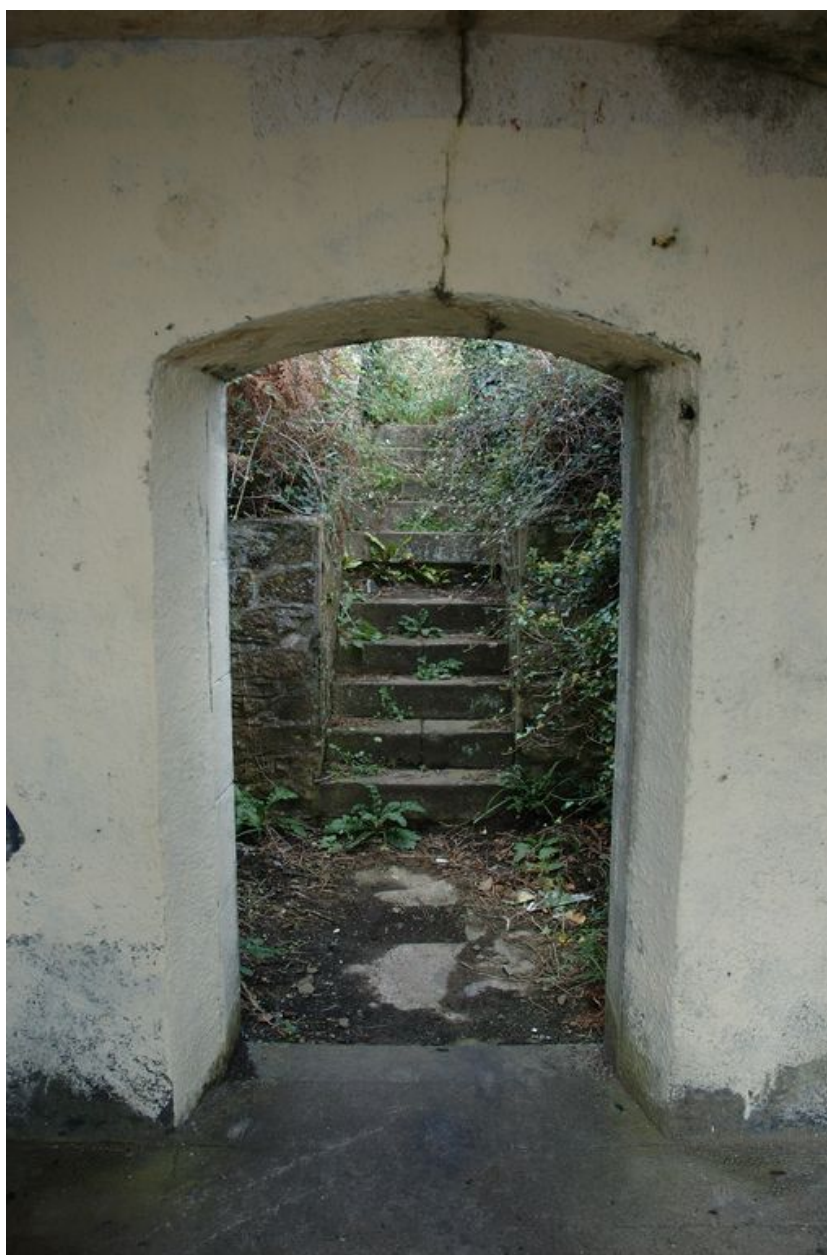
Vue intérieure de l'un des casemates de projecteur (état en 2007)
