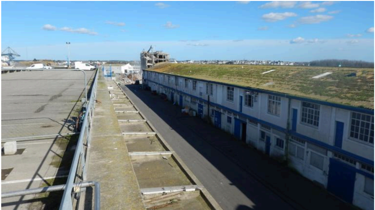
Vue sur les façades des magasins de mareyeurs
