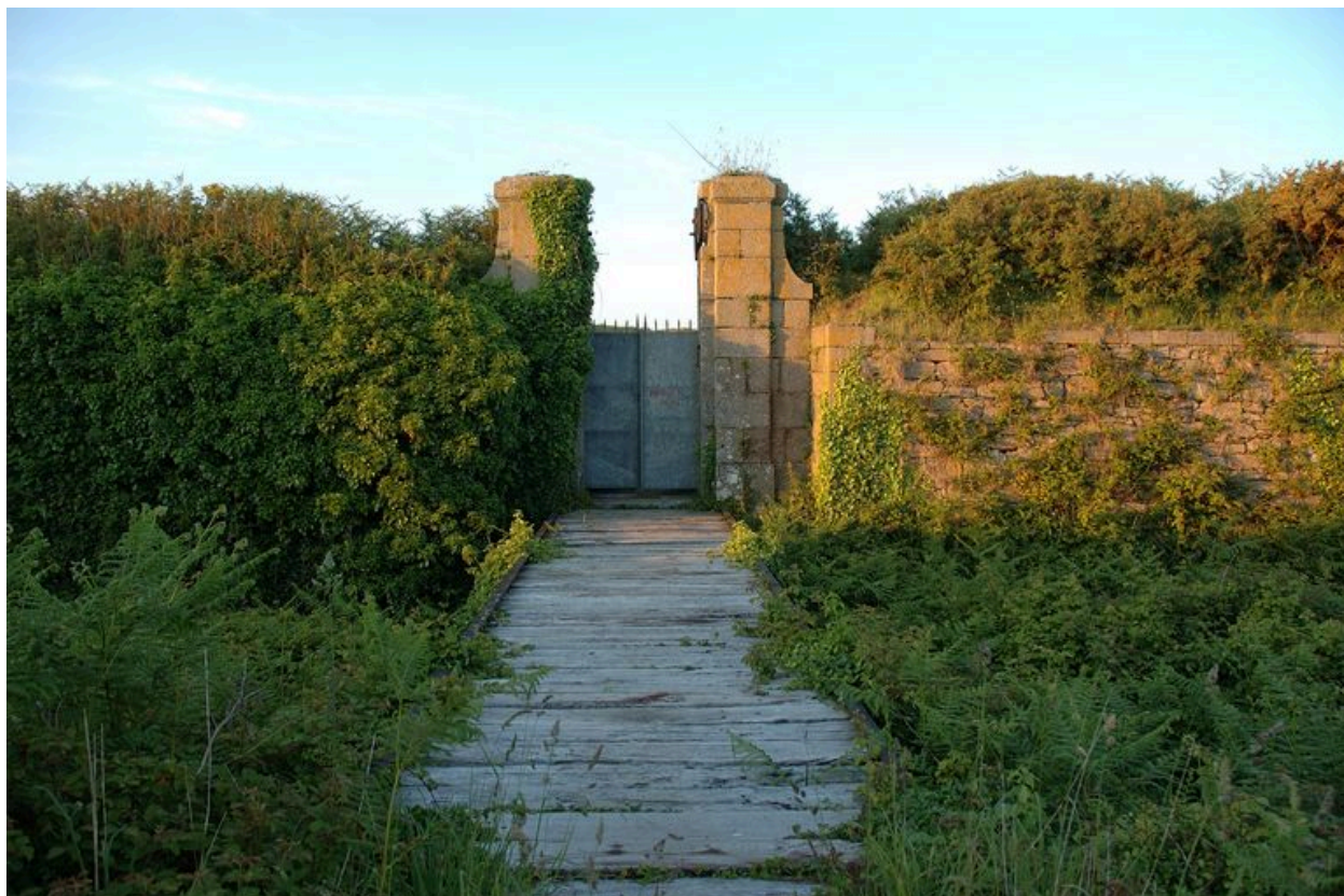
Vue de la porte d'entrée monumentale du fort Cézon
