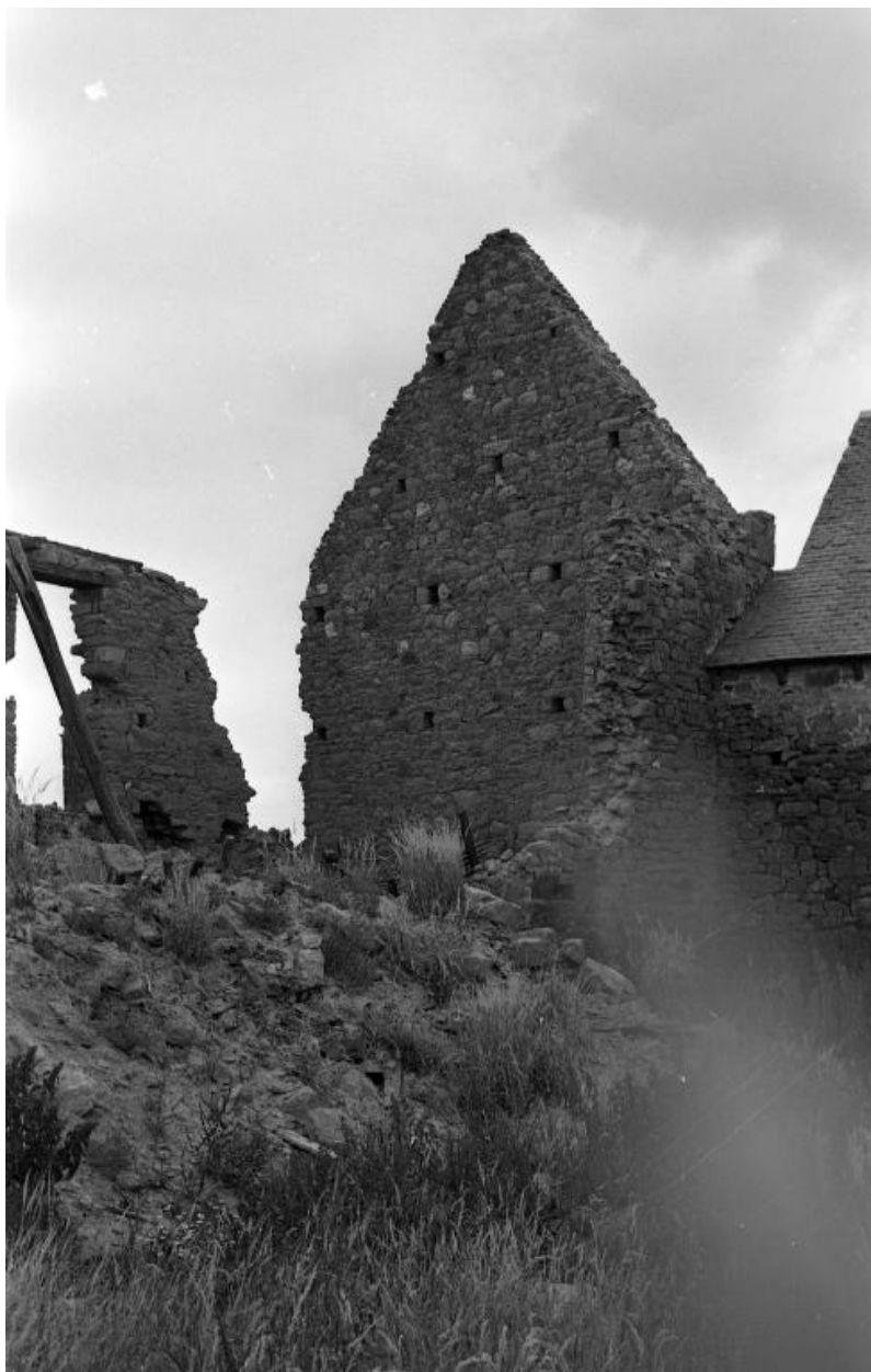
Vue du pignon oriental du manoir et de la bergerie de La Porte
