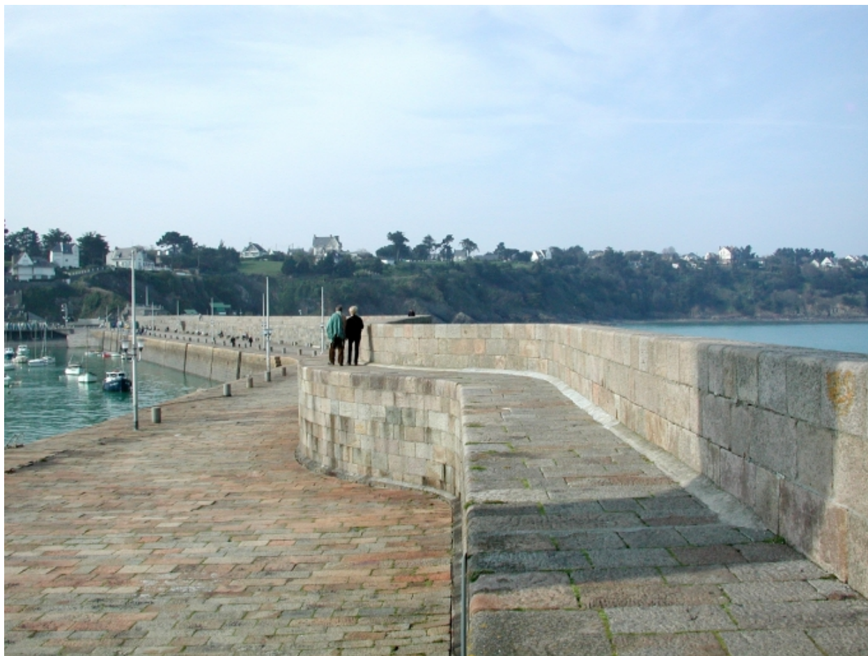
Vue de la forme ondulatoire du parapet
