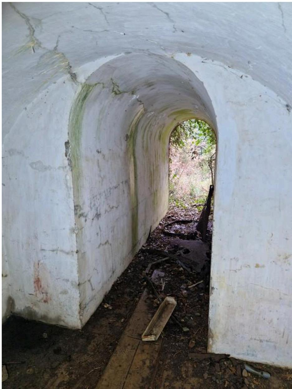
Vue intérieure du magasin à munitions : entrée ouest avec au sol une voie ferrée de 40 cm d'écartement pour le transport des munitions sur wagonnet. Un palan prend ensuite le relai pour la manutention des obus via un palan
