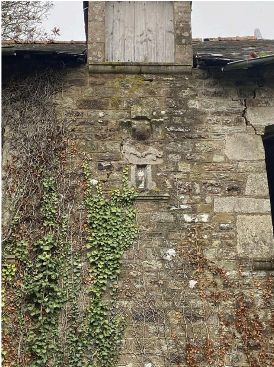
Niche, élévation ouest, détail
