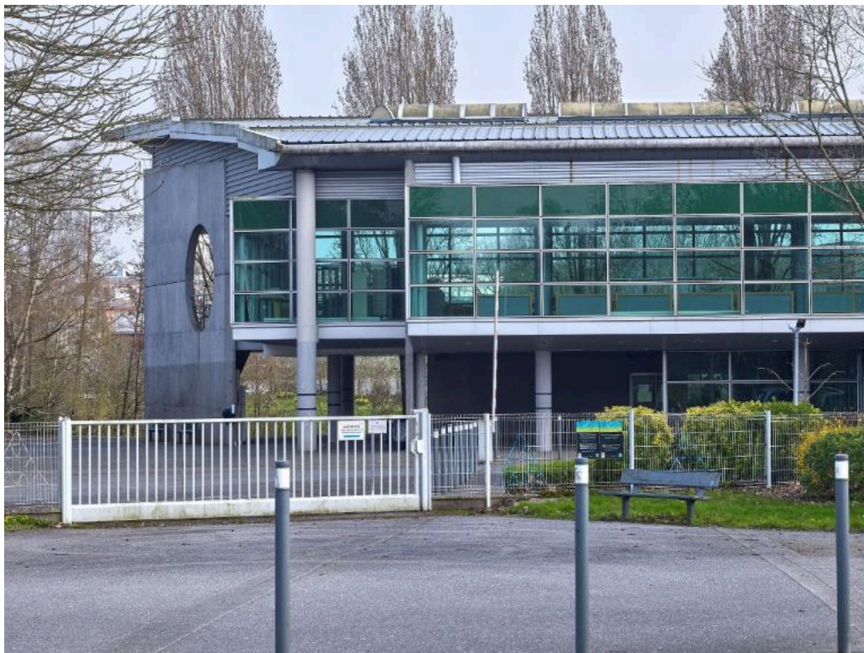
Restauration scolaire, partie nord : réfectoires (étage) et foyer des élèves (rdc). Vue prise de l'ouest. Joël Y. Gautier, architecte, 1992.
