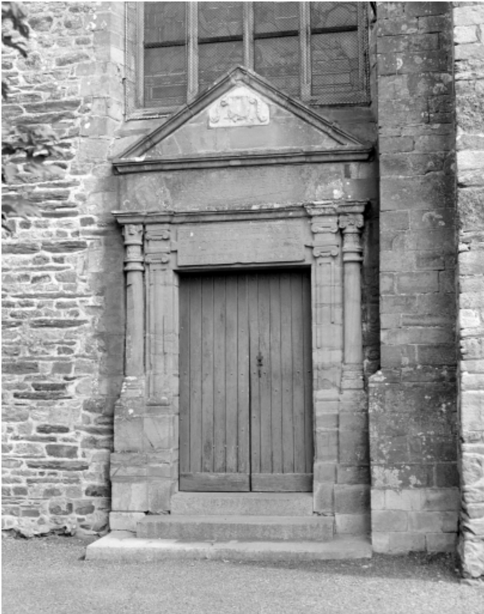
Elévation Sud, porte : vue générale
