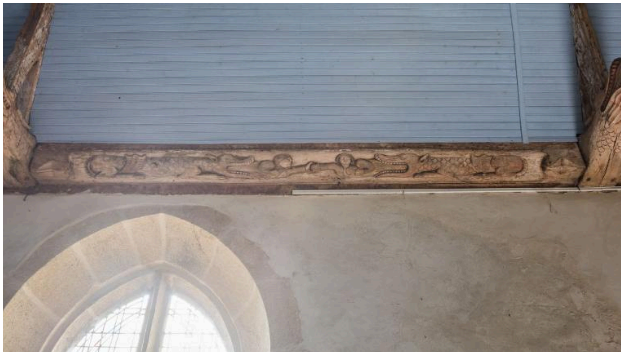
Vue de détail : sablière sud
