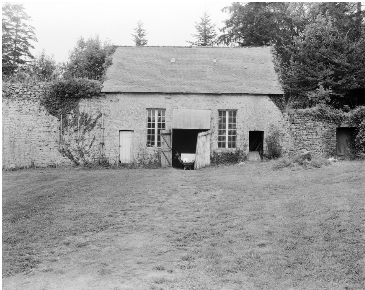
Orangerie, vue générale.
